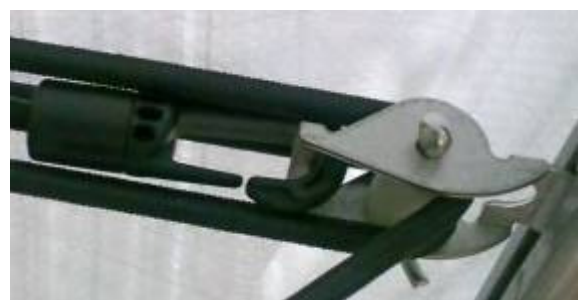
Kuva 16. Asenna rullavaunut näin.
